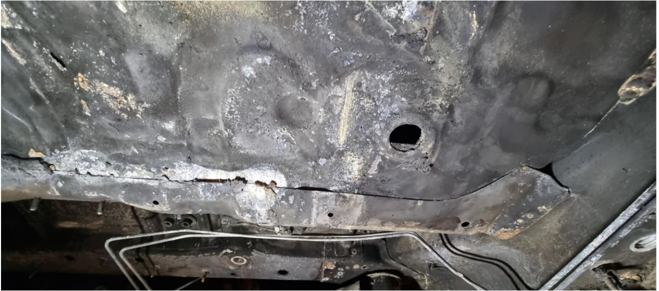
Kuva 7. Oletettu palonalkamiskohta pohjan ja akun välissä.
